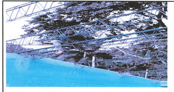
Foto 2: cambio de estructura metalica a techado
