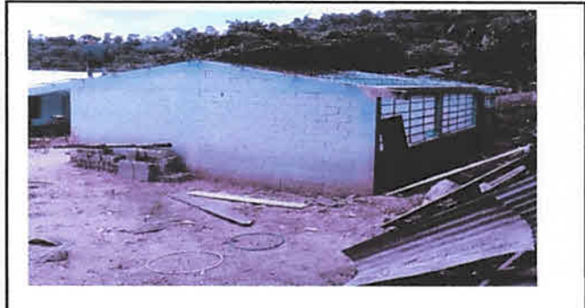
Foto 1: Cambio de techo, por mal estado
